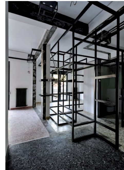
Β. Ο σκελετός της μεταλλικής κατασκευής χωρίς τα πετάσματα πλήρωσης.
