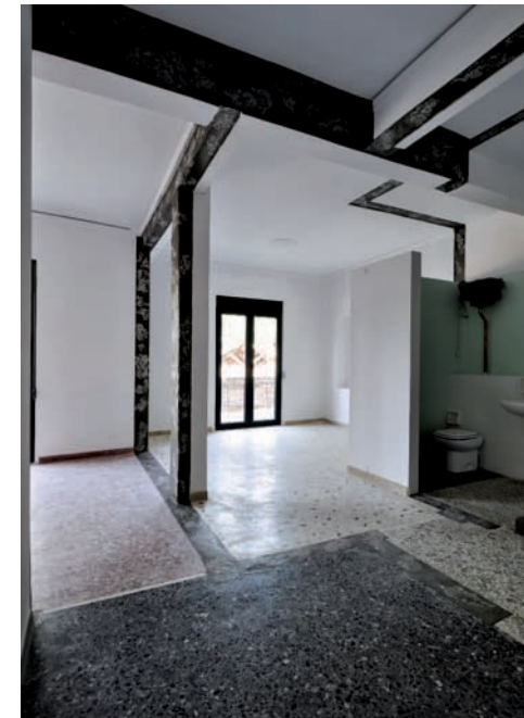
Α. Το διαμέρισμα πριν την εγκατάσταση της μεταλλικής κατασκευής.
